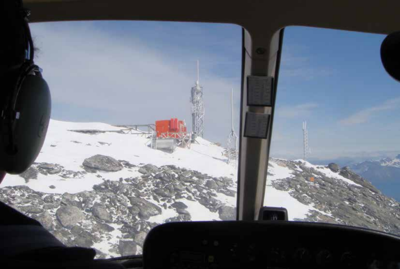
Radiokædestationen på Qingaaq ved Nuuk
